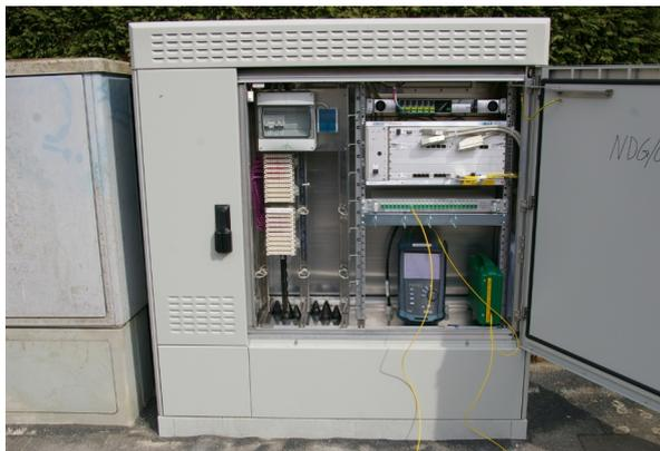
Der KVz wird/ wurde durch das Multifunktionsgehäuse ersetzt, bzw. mit einem Multifunktionsgehäuse ergänzt. Die Verbindung zwischen Vermittlung und Gehäuse erfolgt nun über Glasfaser und nur das letzte Stück zum Haus ist ein Kupferkabel oder bei Bedarf auch eine Glasfaser. Die Telekom hatte diesen Umbau 2018 /19 bewältigt.
