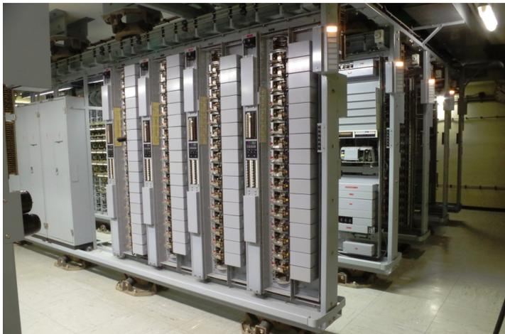
*Vermittlung im ehm. Ausweichsitz des Landes NRW, eine der ganz wenigen EMD-Vermittlungen die noch am Originalplatz voll funktionsfähig sind. Sie diente dem Fernmeldeverkehr im Bunker so wie mit der Außenwelt. Verglichen mit einer „normalen Vermittlung“ weist sie eine Besonderheit auf: Alle Gestellreihen sind mit Dämpfern montiert, die Stöße abfangen sollen.*
